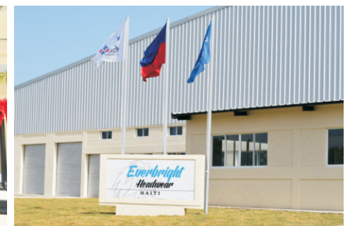
Le local de la manufacture Everbright Headwear à la CODEVI
